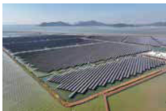
广东某能源集团储能项目
